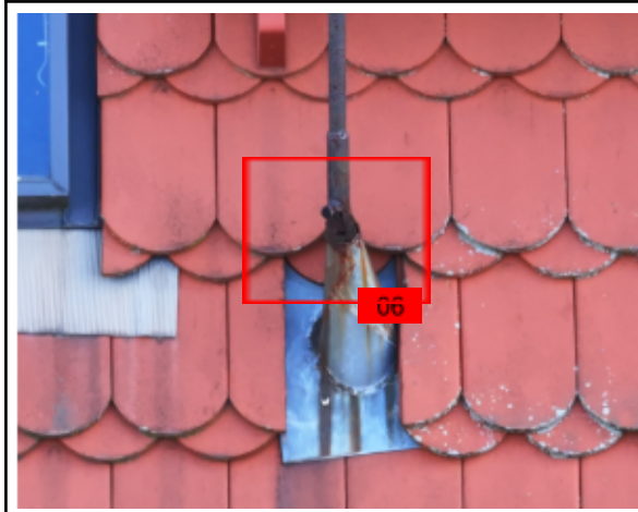
# 06 zardzewiałe mocowanie masztu Istotność: 5
